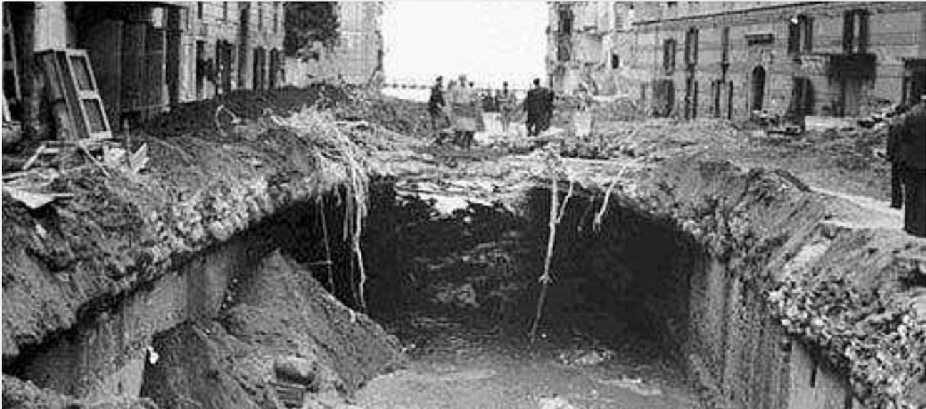
Alluvione di Salerno del 1954 - Sprofondamento della copertura dell'alveo del Torrente Regina Maior nell'abitato di Maiori (Foto del SIMN)
